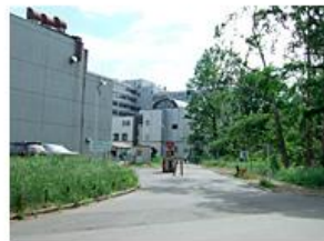
10 工学部北口玄関前
