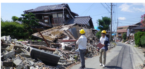
熊本地震実地調査(益城町)
